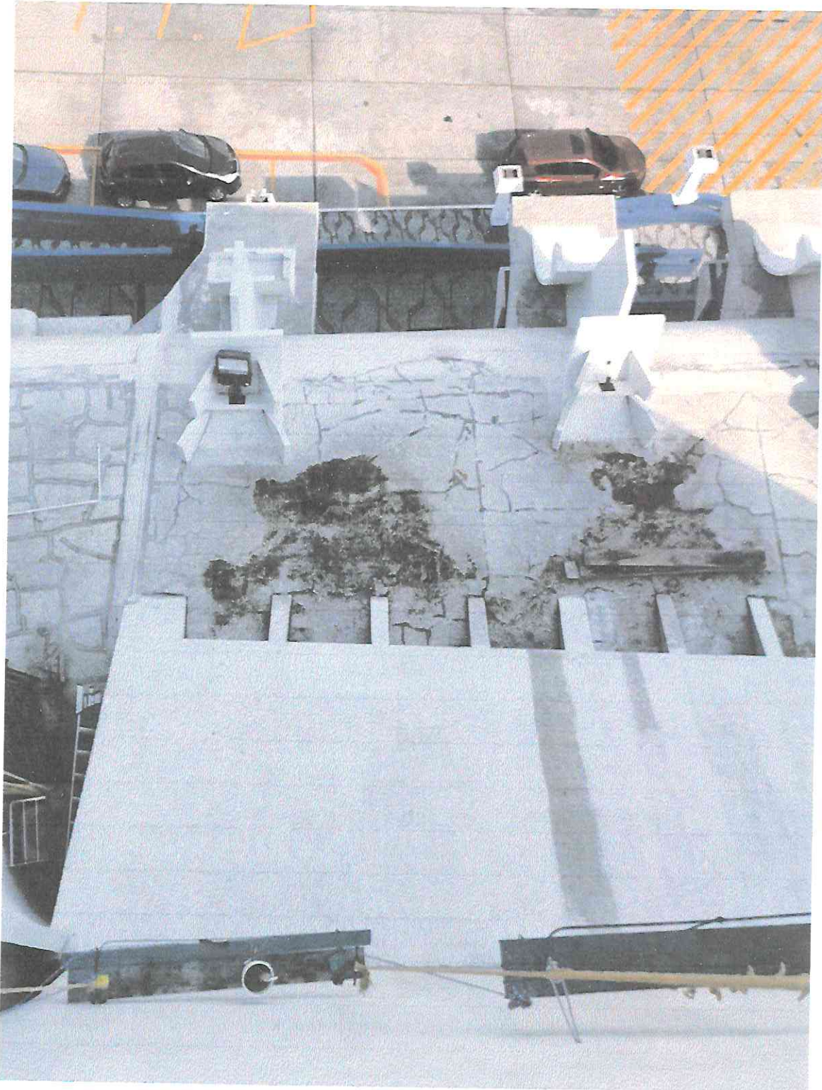
Limpieza y desinfección de teselas en segmento B2 de fachada Oriente.
